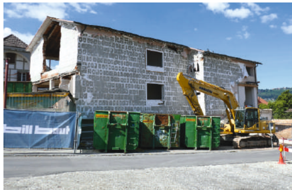
Abbrucharbeiten am alten Schulgebäude mit Turnhalle...
